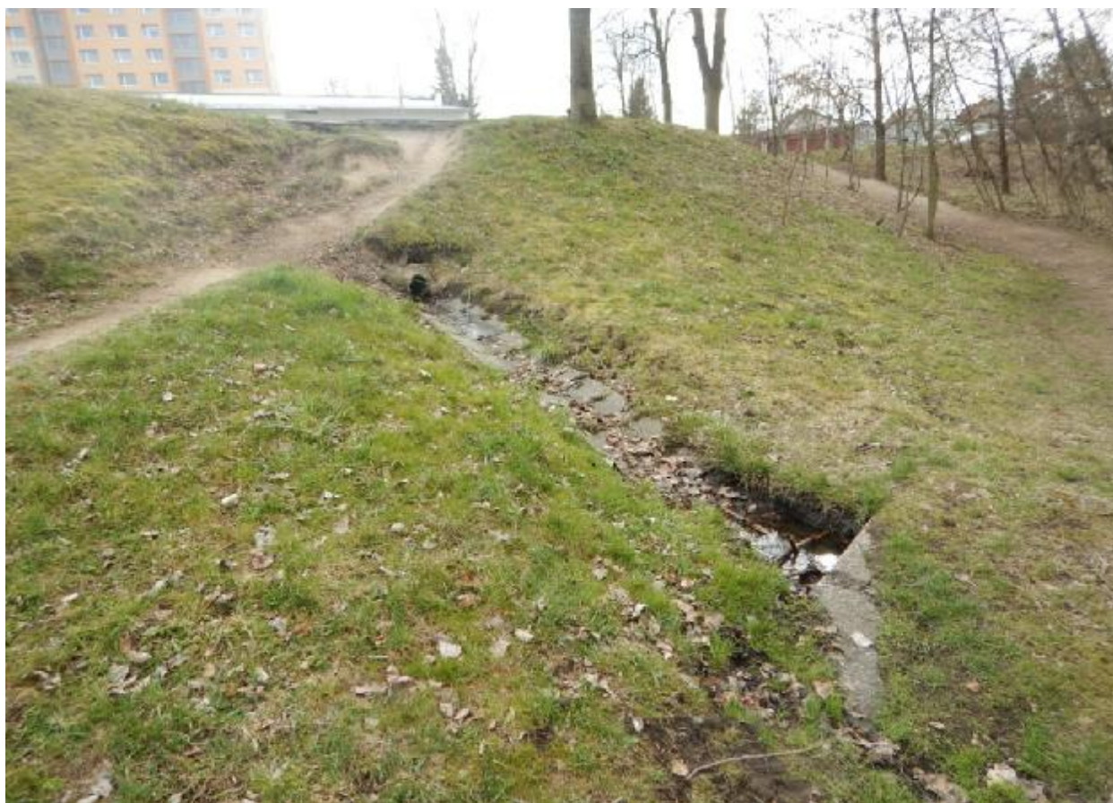
Obrázek 10 Problematické místo A odvodnění u silnice, vyústění odvodnění silnice
